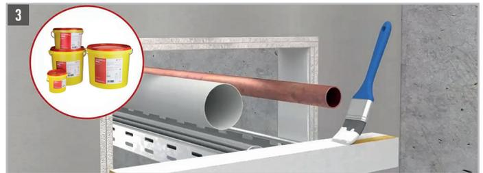
Die Rohrschleifen sind bei Einbau der Kombiabschottung in Wände beidseitig der Wand und bei Einbau in Decken deckenunterseitig anzuordnen. Es muss die zum jeweiligen Rohraußendurchmesser jeweils passende kleinste Rohrschleife verwendet werden.
